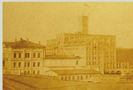
Il mulino della Hildebrandsche Mühlenwerke AG a Halle an der Saale
